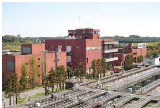
守谷浄化センター
