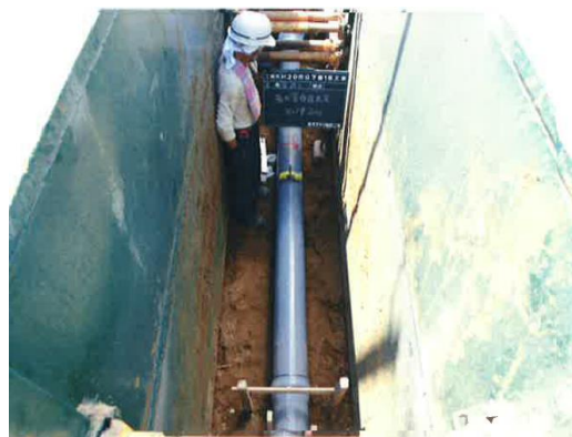
汚水管布設工事
