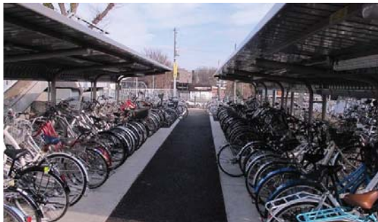
新守谷自転車駐車場
