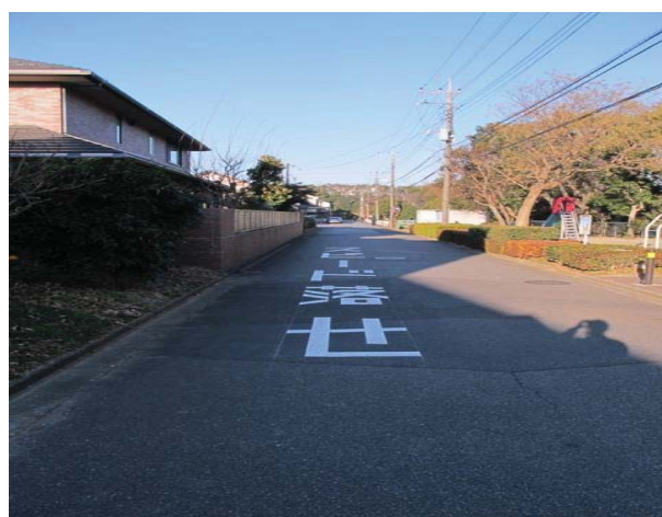
注意喚起の路面標示
