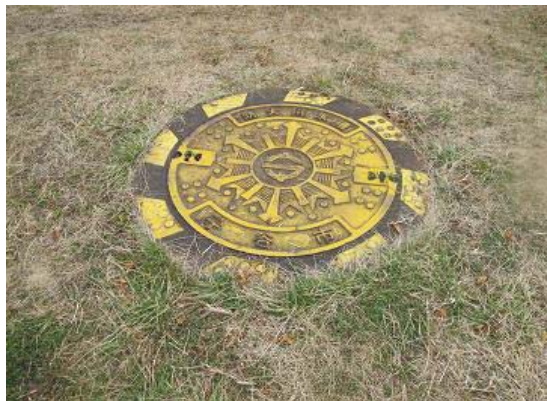
耐震性防火水槽
