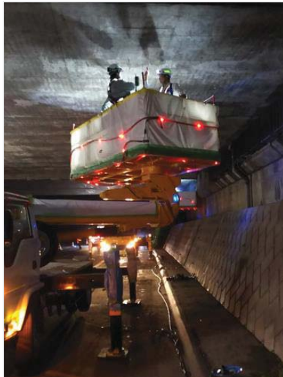
北守谷橋の補修作業状況
