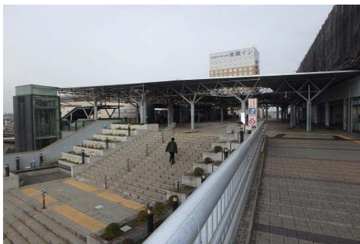
守谷駅自由通路
