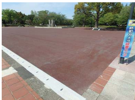
公園改修工事が完了した立沢公園（カラー舗装）
