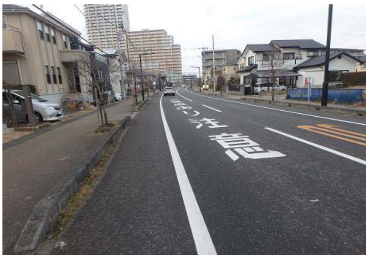
区画線設置(市道106号線)
