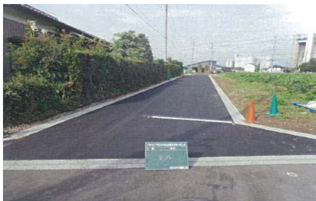
拡幅改良が完了した市道2735号線(大柏地内)
