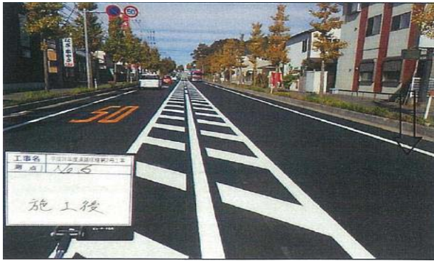
舗装工が完了した市道101号線（けやき台）
