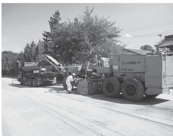
▶中学校校庭の放射線量低減化工事状況
