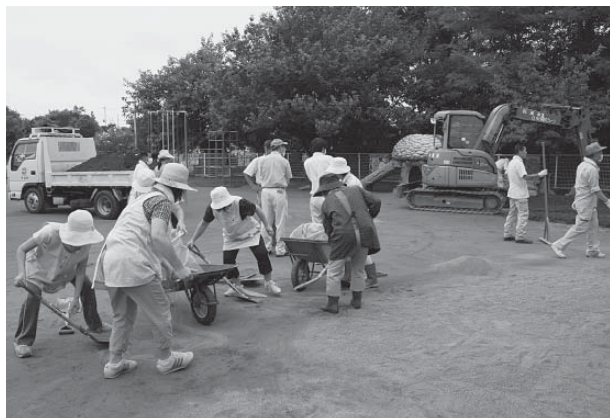
（守谷市内保育園除染作業の様子）
