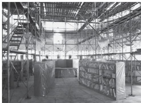
復旧工事の様子（2階吹き抜け部分の足場組み）
