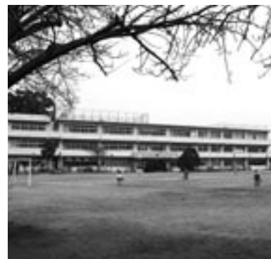
▲耐震・改修工事を予定している大野小学校（大野小学校改築事業）
