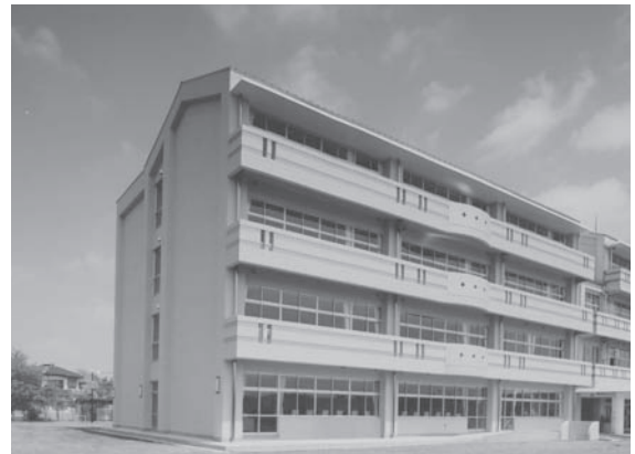
▼けやき台中学校の増築した校舎
