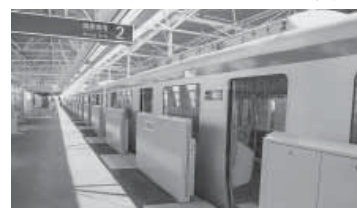
▲安全に配慮した可動式ホーム柵
