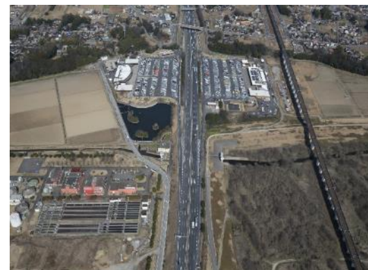
守谷サービスエリア周辺状況
