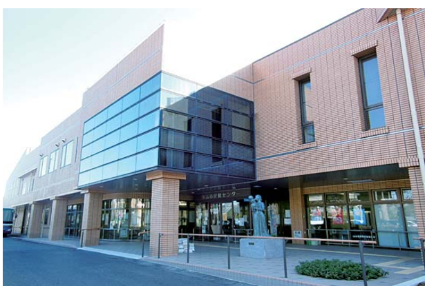
守谷市保健センター
