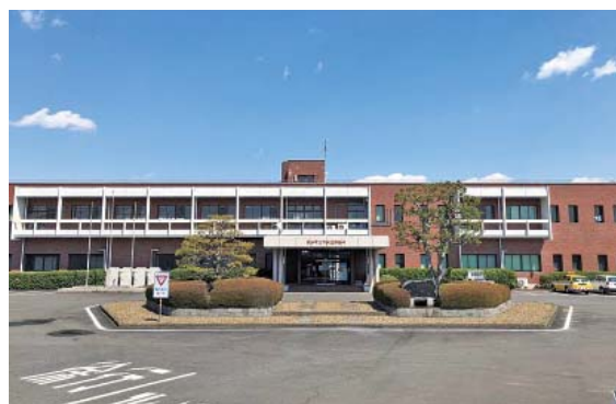
上下水道事務所
