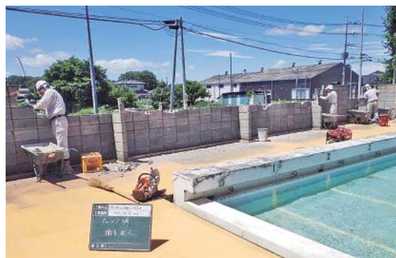
ブロック塀撤去作業
