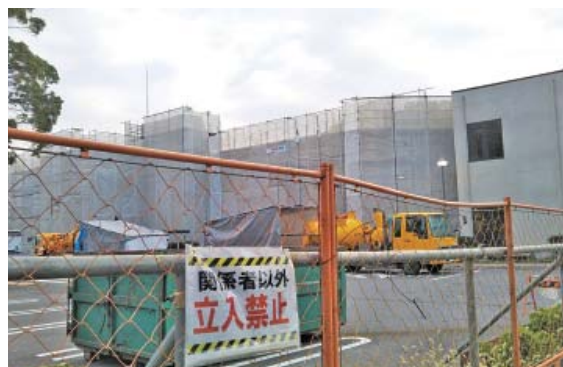
中央公民館改修工事
