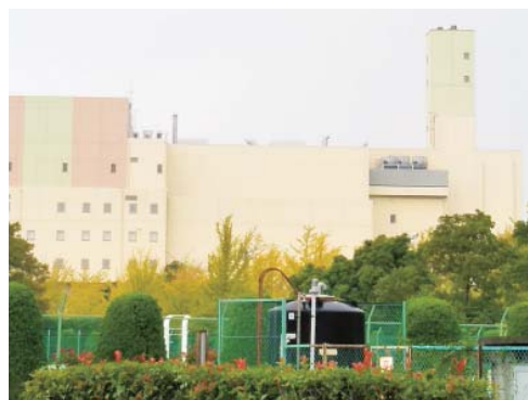
常総環境センター
