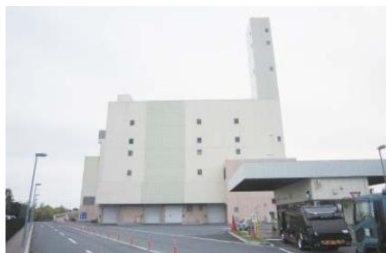
常総環境センター
