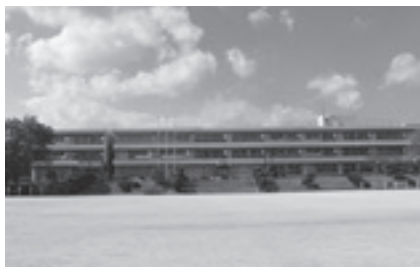
増築予定の黒内小学校
