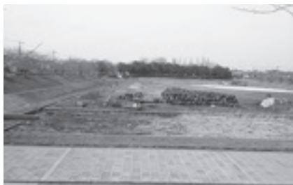
除染作業中のみずき野第一調整池
