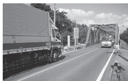
渋滞解消が期待される滝下橋
