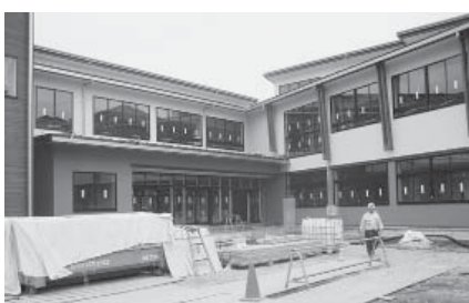
完成間近な校舎
