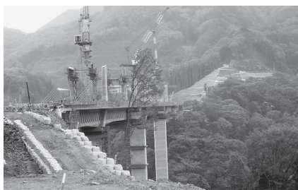
地域を結ぶ橋梁
