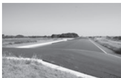
稲戸井調節池の越流堤
