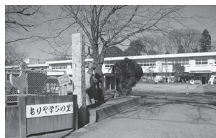
昭和42年建築の元小学校校舎
