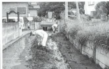
大雨による土砂の流出
