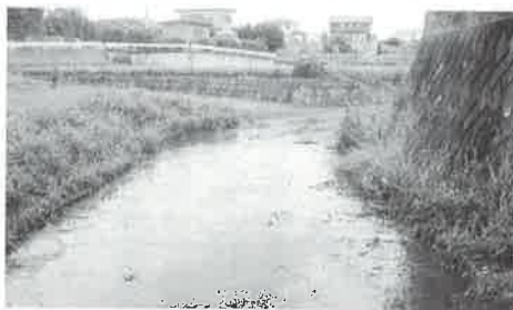
大雨による冠水
