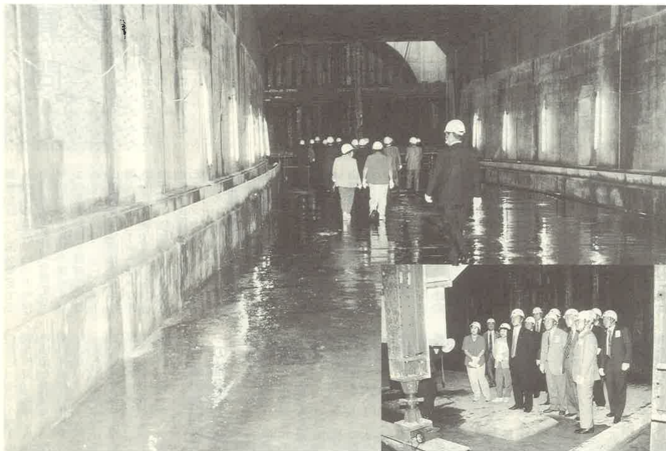
常磐新線西綾瀬トンネル工事現場視察（常磐新線等守谷・伊奈・谷和原議会連絡協議会）
