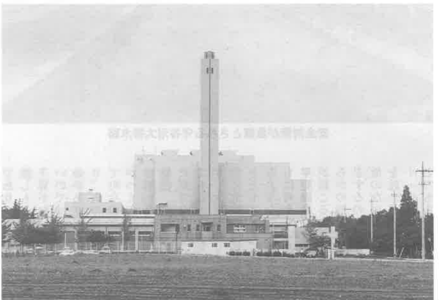
ごみの分別・減量化の徹底を（常総環境センター）
