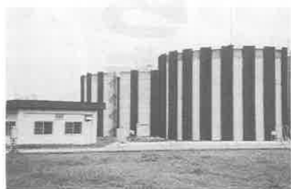
水道事務所給水タンク
