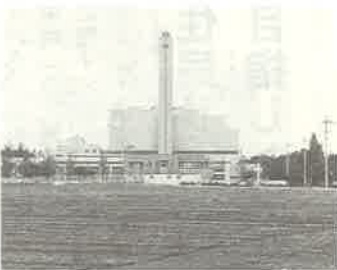
常総環境センター
