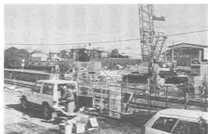
常磐新線守谷駅部工事
