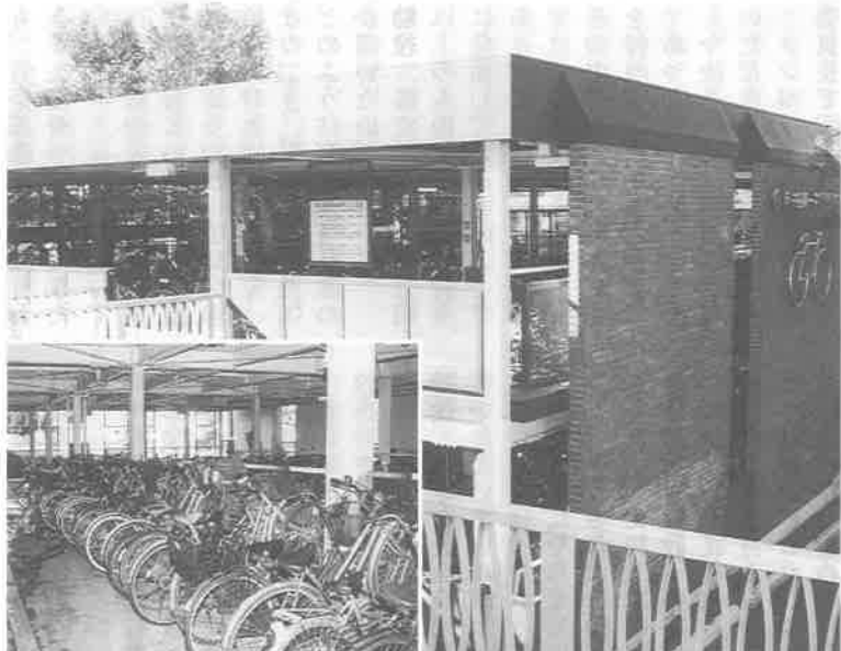
新守谷第一自転車駐車場
