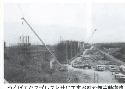
つくばエクスプレスと共に工事が進む都市軸道路
