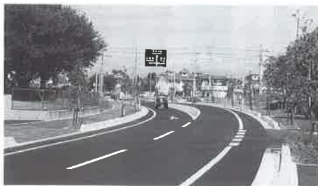
開通した都市計画道路「坂町・清水線」
