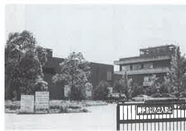
守谷浄化センター
