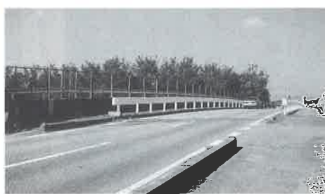
常磐道立沢橋
