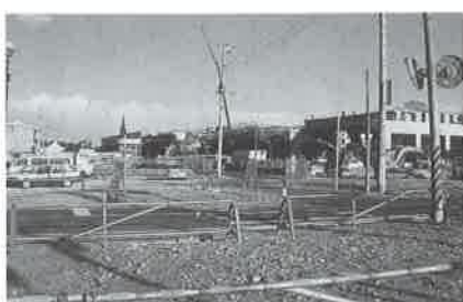
H17年の開業に向け工事が進む駅周辺
