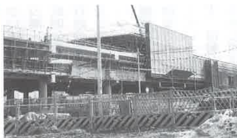
工事が進むつくばエクスプレス守谷駅
