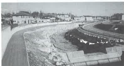
守谷東区画整理地内プロムナード式水路
