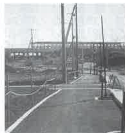
工事の進む守谷駅周辺
