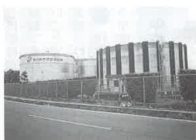
工事が完了した配水池(ステンレス製)
