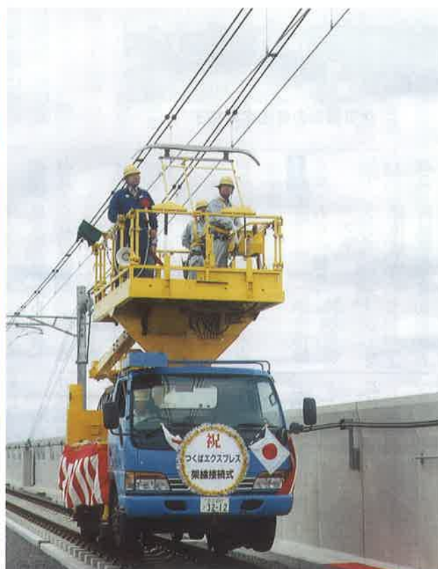
架線接続用特殊車両 (TX 架線接続式・大柏付近)
