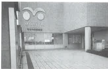
改修予定の図書館進入路アプローチ
