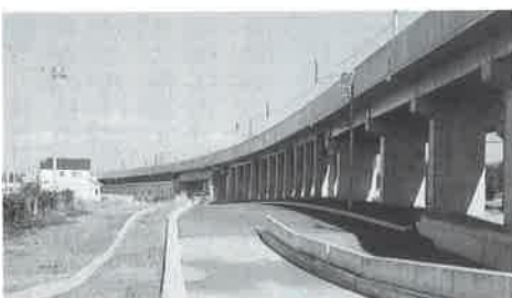
都市軸道路守谷・伊奈・谷和原線
