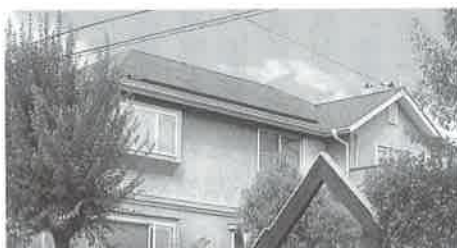
自然エネルギーの活用を (太陽光発電システム)
