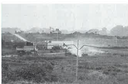
大木流作地区の盛土工事
