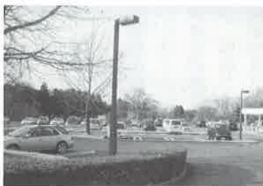
市役所駐車場内の外灯
