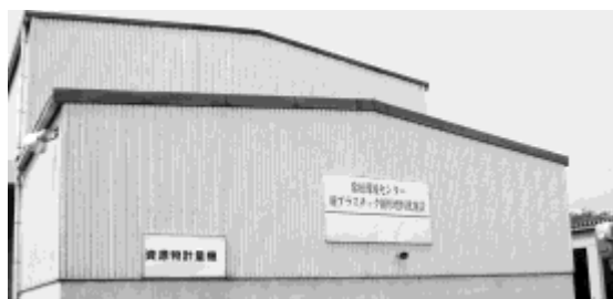
ペットボトルの処理を行う廃プラ施設
