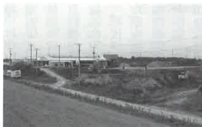
盛土事業が進行する大木流作地区
