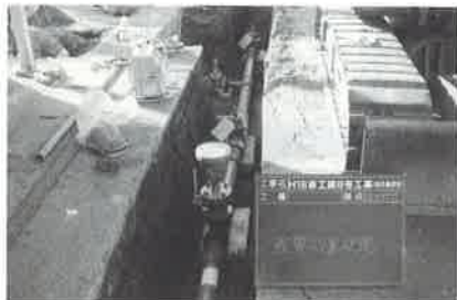
配水管布設替えの様子（上町地内）
