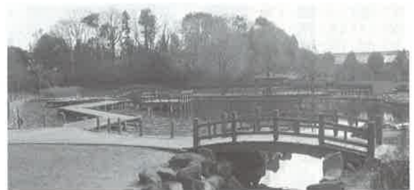
改修工事予定の四季の里公園
