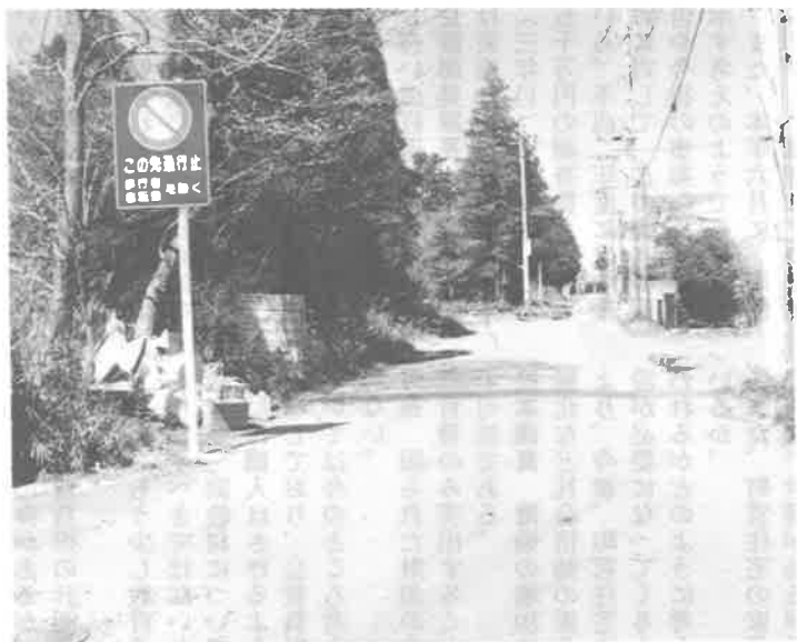
分断された町道109号線
