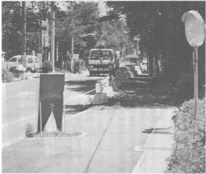
黒内小学校入口の仮設歩道
