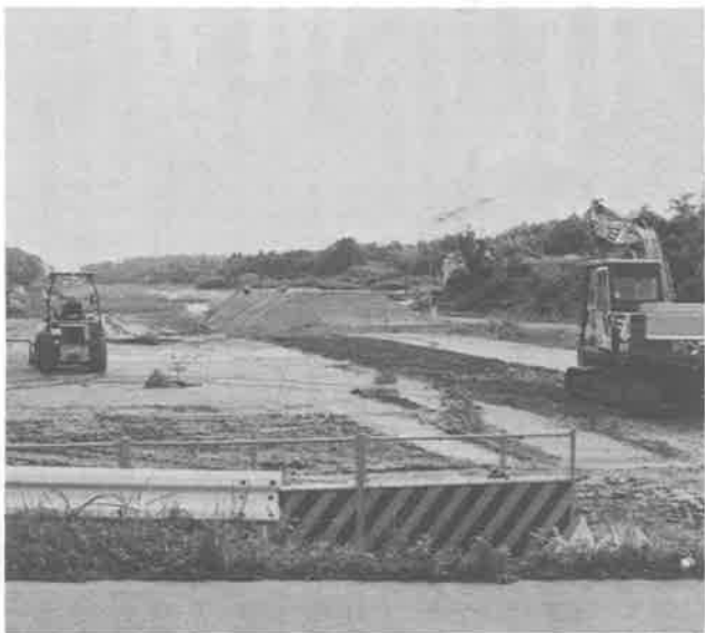
造成工事がはじまった守谷東土地画整理事業
