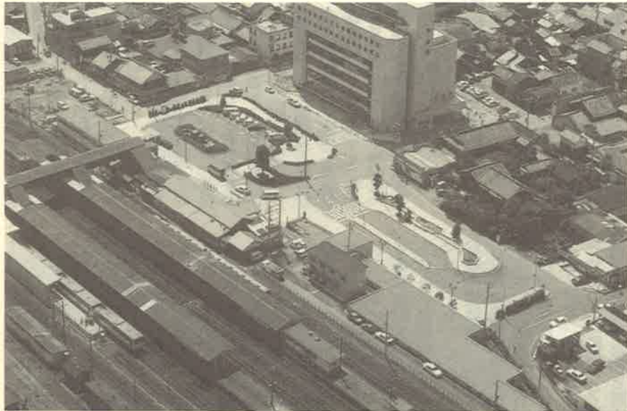
整備された美濃太田駅前広場
