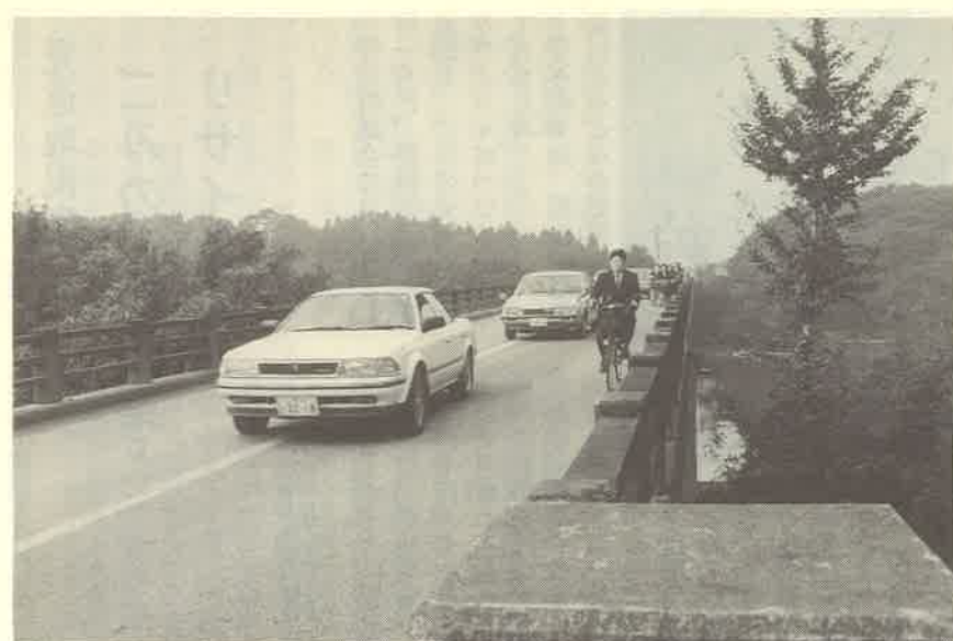
自転車歩行者専用橋の設置が望まれる常総橋
